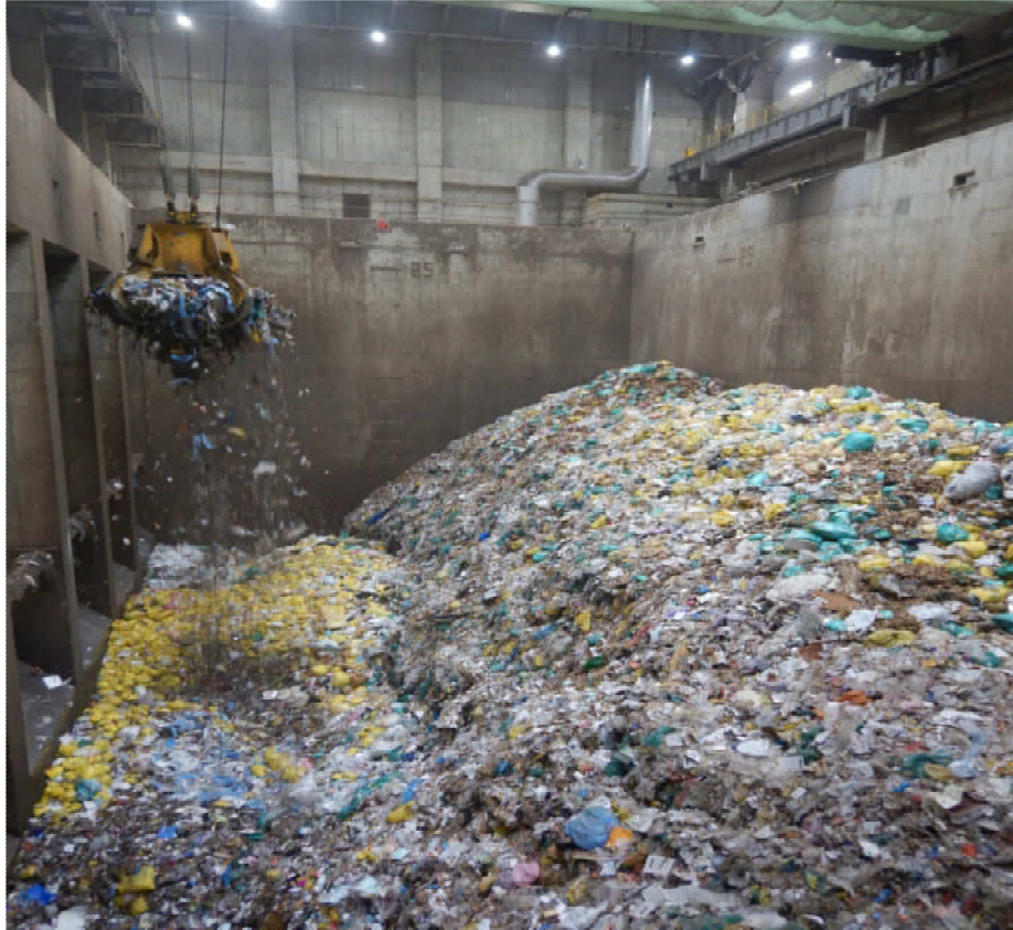
可燃ごみ処理施設ごみピット
