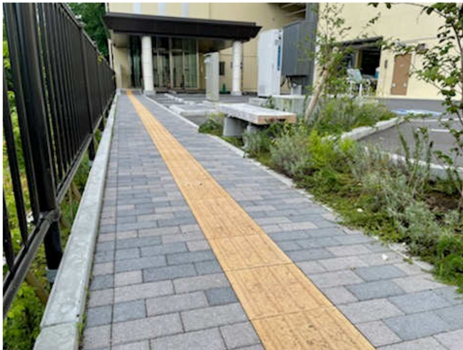
当施設エントランス部
