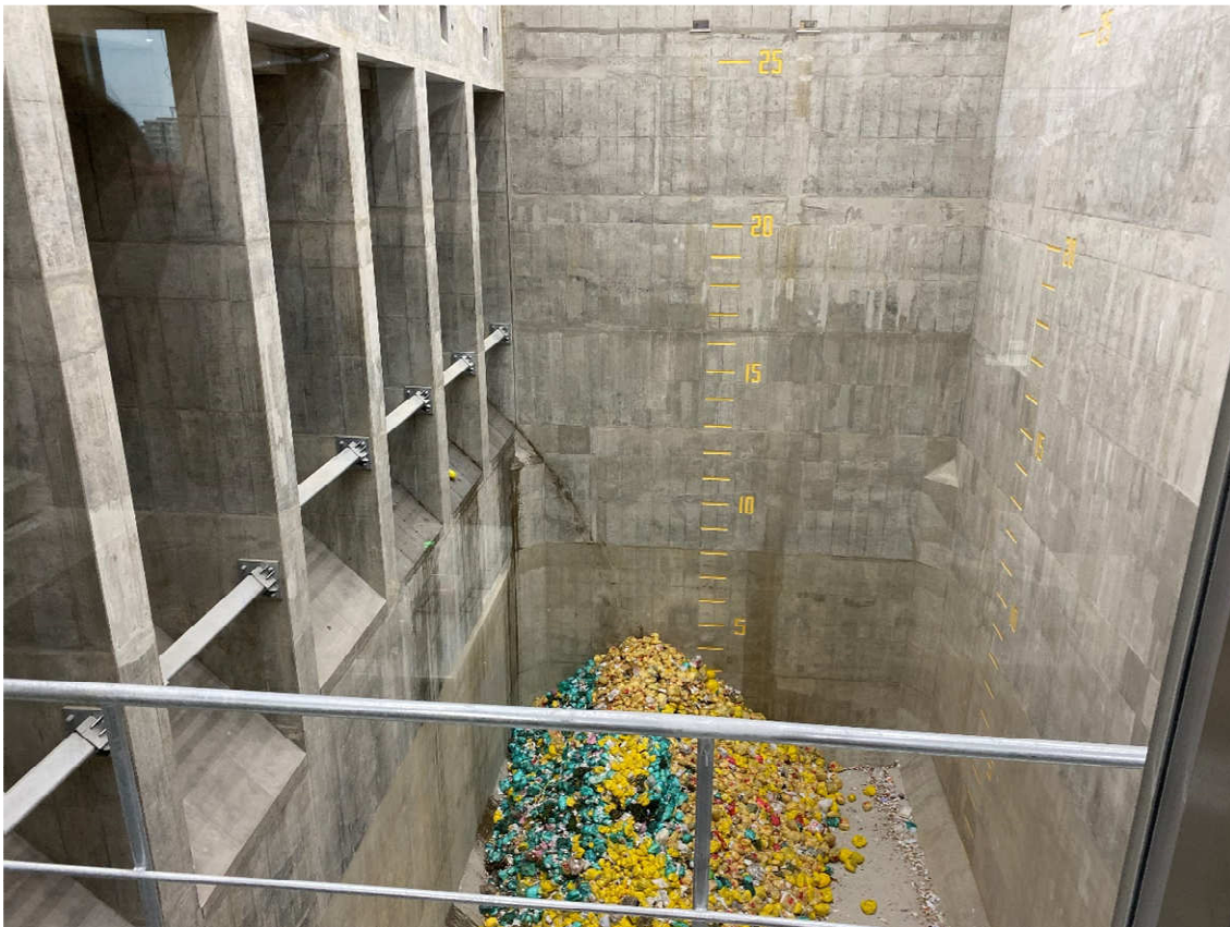
可燃ごみ処理施設ごみピット
