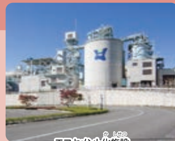
エコセメント化施設
