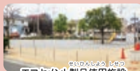
エコセメント製品使用施設
