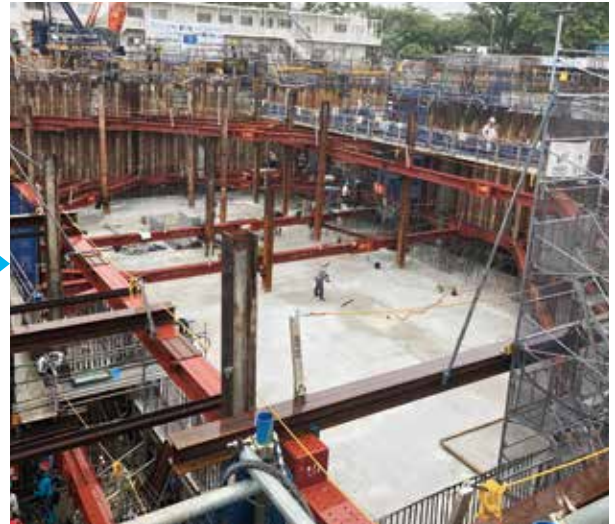
コンクリート打設後
