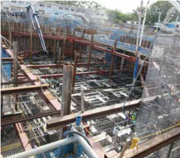
コンクリート打設前
